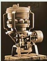
erfindet Friedrich Fischer die Kugelschleifmaschine und ermöglicht die Erfolgsgeschichte des Wälzlagers. Ursprünglich für Fahrräder konzipiert, revolutionierte das Wälzlager bald auch die Herstellung von Motorrädern, Autos, Flugzeugen und Eisenbahnen. Seit 2001 gehört FAG Kugelfischer zu Schaeffler.
