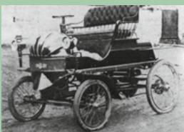
Hybrid-Pionier: In der Pieper Voiturette aus dem belgischen Lüttich lädt erstmals ein Verbrennungsmotor die Batterie für das Elektroantriebsaggregat. Das Foto zeigt ein Modell von 1900.
