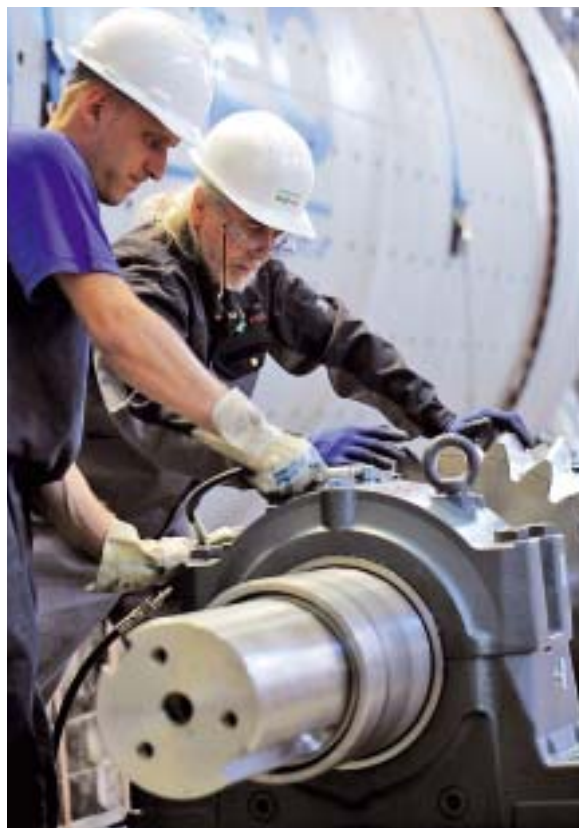
Schaeffler-Montageexperte Hans-Joachim Zillmer (rechts) unterstützte bei der Montage der neuen SNS-Gehäuse bei Cemtec in Enns, Österreich
