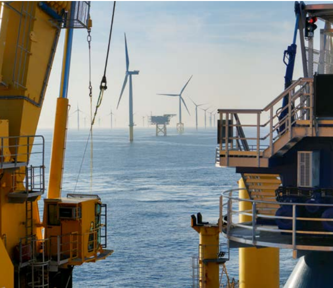
Ein Blick von der Umspannstation auf die Windräder des Offshore-Parks „Borkum Riffgrund“ – und auf die „unendliche“ Weite der Nordsee
